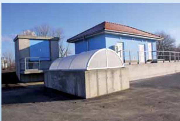
Retenční nádrž na levém břehu řeky Bečvy Přerov
