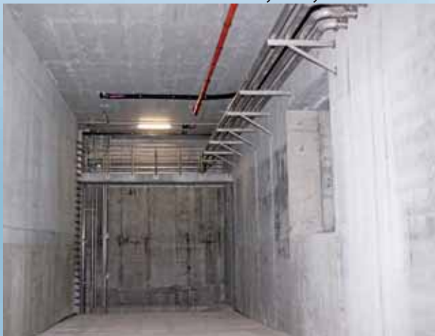
Retenční nádrž na levém břehu řeky Bečvy Přerov
