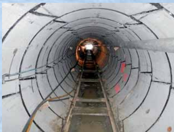
Přerov, sběrač Z - ražba štítem
