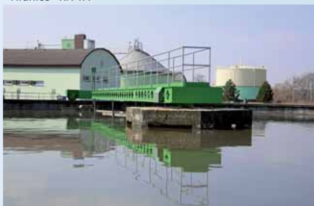
ČOV Přerov - pojezdový most UN
