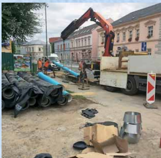
Přerov, vodovod DN 250 - Komenského ulice
