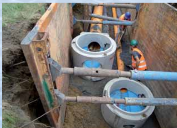
Hranice - kanalizace Pod Křivým
