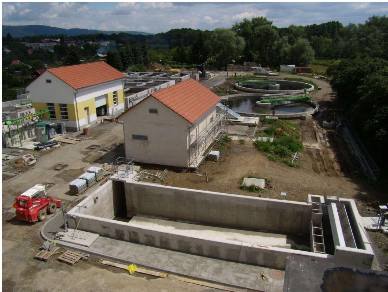
Rekonstrukce čistírny odpadních vod Lipník nad Bečvou
