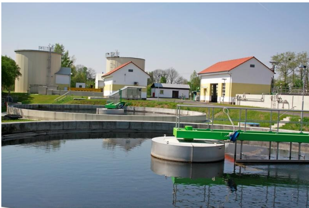
Čistírna odpadních vod Lipník
