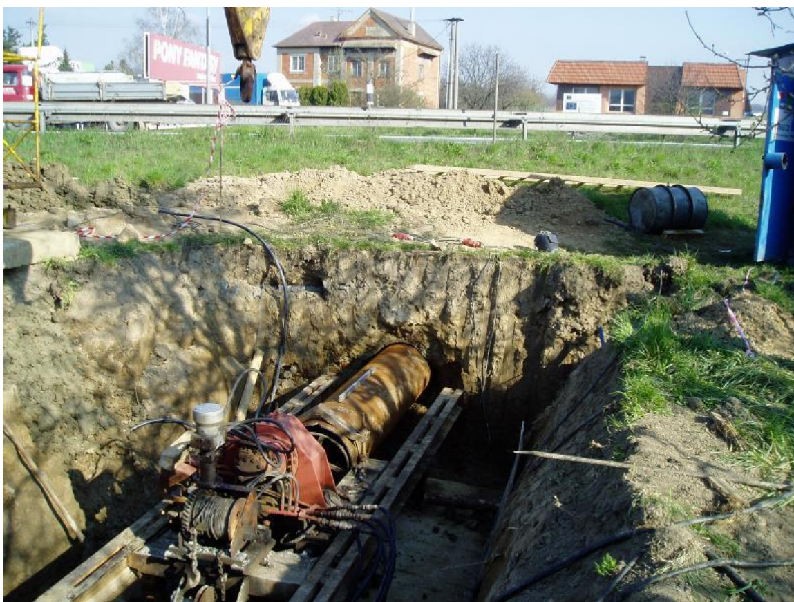
Drahotuše – protlak potrubí pod silnicí
